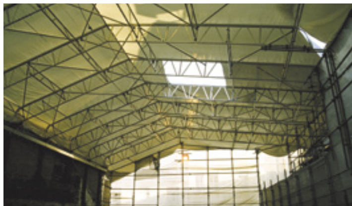
Cantiere: Kantieri S.r.l. in Treviso
